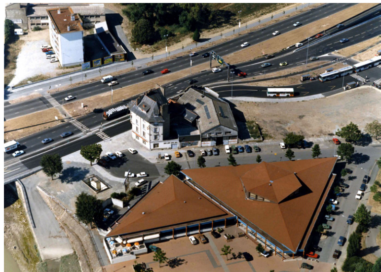
Le garage de la Sèvre derrière le bâtiment de l'ancien octroi - 1986
