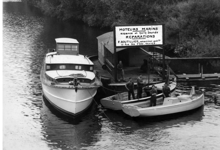
Le ponton sur la Sèvre pour la réparation des bateaux
