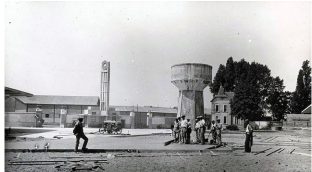
Cour intérieure des abattoirs en construction - 1932
