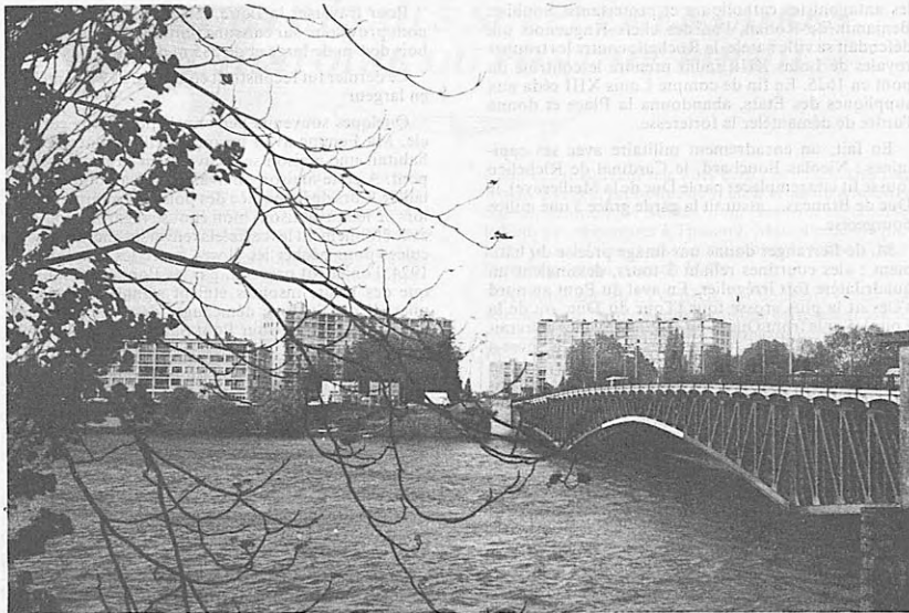
1989 - Le Pont de Pirmil - (Photo S. Pageot)
