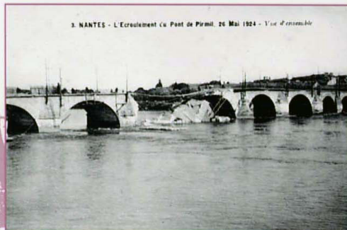
L'écroulement du pont de Pirmil en 1924. Carte postale.
