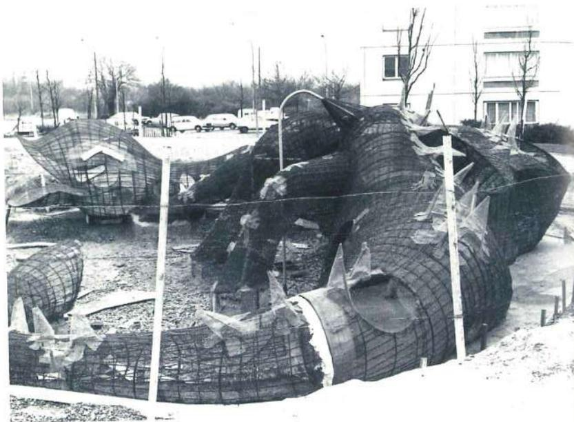
Le « squelette » de « Boit-sans-soif » avant d'être recouvert de béton.
