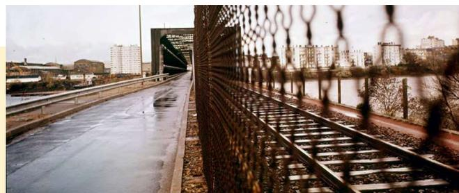
Le pont de Pornic dans les années 1960. En attendant l'ouverture de la nouvelle ligne de ponts, une voie unique déviée à la circulation routière est aménagée en 1966 sur l'ouvrage ferroviaire afin de désengorger le pont de Pirmil.
