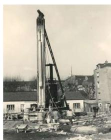
1953, appareillage pour le coulage des pieux Franki : un tube de 9 m de longueur et de 40 cm de diamètre était enfoncé afin de permettre le coulage du béton à l'intérieur. De janvier à mars 1953, cet appareil a permis de couler 144 pieux de béton armé.
