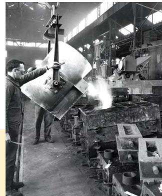
Vue du travail de fonderie proprement dit avec un ouvrier coulant du nantais en fusion.
