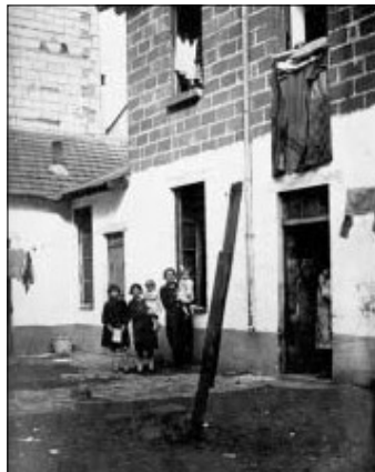
Derrière la façade des rues du Marchix, des cours insalubres.
