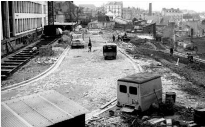
La construction de la Poste, rue Cassegrain, sur l'ancien site du Marchix.
