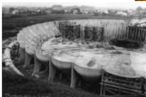
Construction de l'un des réservoir dans les années 30.
