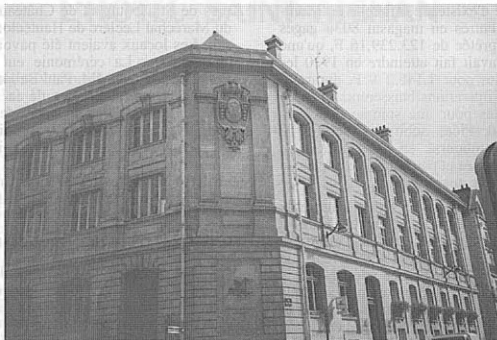
L'immeuble du Crédit Municipal
