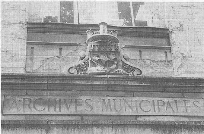
Entrée de l'ancien bâtiment d'archives rue Saint-Léonard avec le fronton et la sculpture des armes de la ville.
