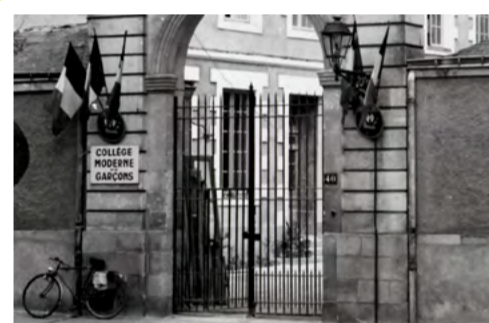
Entrée principale du collège moderne de garçons de la rue de Bel-Air en 1954.
