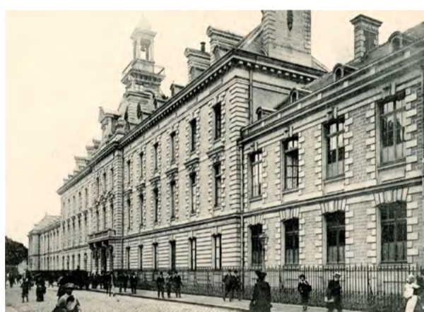
Façade sur la rue du Lycée (actuelle rue Georges-Clemenceau), vers 1900.
