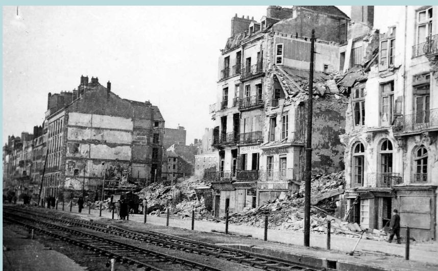
La voie ferrée située sur le quai est hors d'usage. Les immeubles effondrés sur cette photographie ne seront pas reconstruits et laisseront la place pendant de nombreuses années à un parking. Ce n'est qu'en 1985 qu'est inaugurée sur cet emplacement la médiathèque Jacques-Demy. Les immeubles du 18e siècle endommagés ont été restaurés à l'identique.
