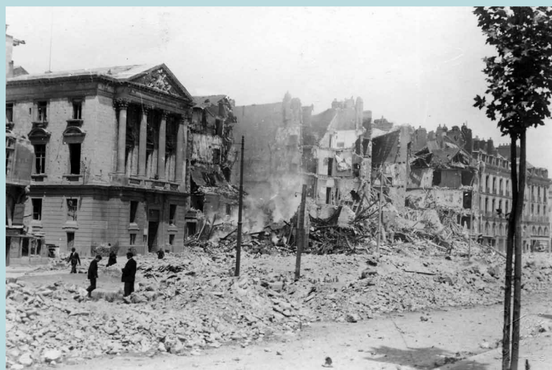
Les immeubles de l'allée Brancas ont été très touchés. L'ancien hôtel des Postes et Télégraphes encore debout a été détruit quelques années plus tard.
