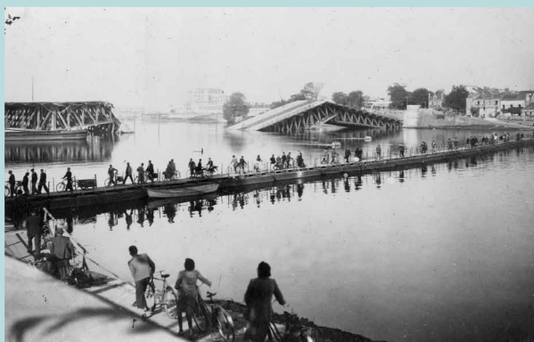
Une passerelle provisoire est mise en place en août 1944 pour traverser la Loire.
