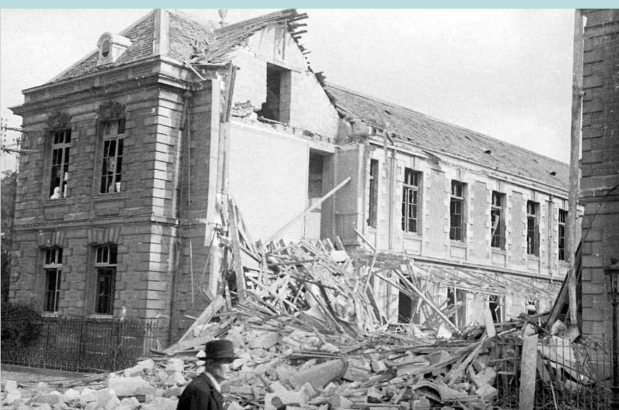
Le lycée Clemenceau, petit et grand lycée, est lourdement endommagé lors du bombardement du 23 septembre en particulier la partie gauche de la façade de la rue Clemenceau qui s'effondre. Suite à ces destructions le lycée est fermé pour l'année scolaire 1943-1944. Seuls les élèves au baccalauréat et des classes préparatoires bénéficient de cours dans plusieurs annexes. Le lycée est de nouveau touché lors des bombardements de juin et juillet 1944.
