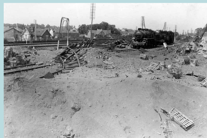
Quartier de Doulon, les voies ferrées et le pont de la Vendée sont touchés lors du bombardement du 12 juin 1944, la gare de triage du Grand-Blottereau le 23 juin 1944.
