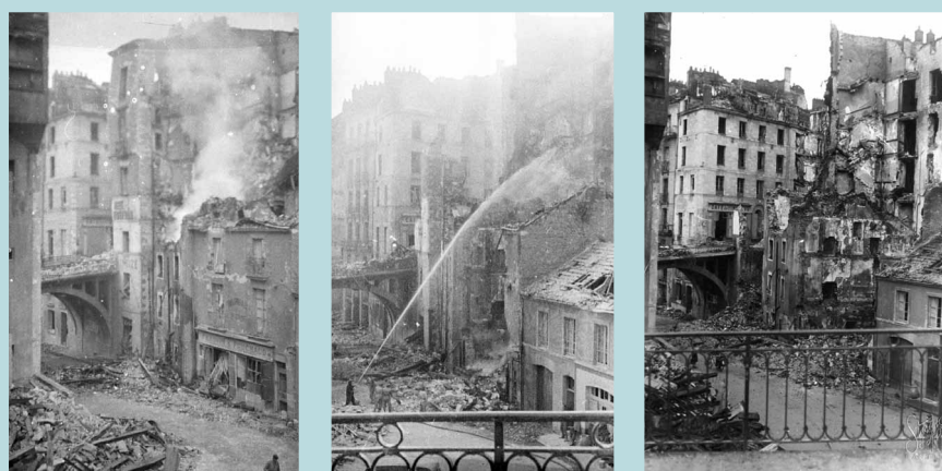
Rue de l'Arche-Sèche vue depuis le pont Sauvetout. L'îlot entre le marché de Feltre et la rue des Deux-Ponts a été totalement reconstruit.
