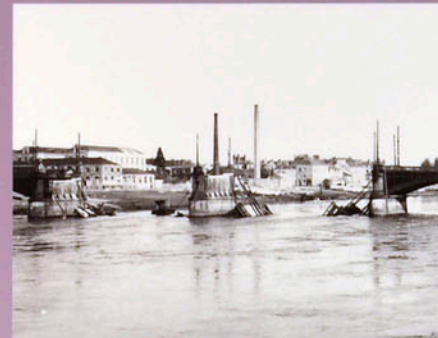
Pont Haudaudine. Construit en 1878, le pont Haudaudine présente 7 arcs dont deux furent détruits. Celles-ci furent remplacées par deux arcs en acier. Après une réfection complète de la chaussée, le pont est remis à la circulation le 17 août 1945.
