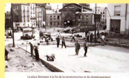
La place Bretagne à la fin de la reconstruction et du réaménagement
