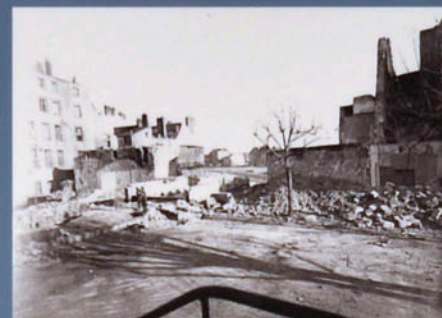
Ecole du Chêne d'Aron, construite en 1879, elle fut réquisitionnée par l'armée allemande le 7 juin 1941 et bombardée les 16 et 13 septembre 1943. Installée en 1947 dans des baraques, elle fut reconstruite plus grande en 1957 comprenant une école de garçons de 9 classes et une école maternelle de 3 classes.
