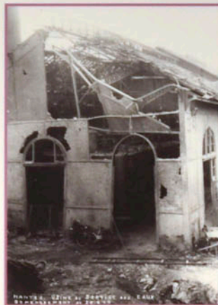
Photo destruction 2 (13/1525) : Au-delà de la destruction des bâtiments, l'usine de la Roche comptera cinq employés "morts en services commandés". Bien que protégés dans un abri anti-aérien construit en 1940, ils périrent sous le souffle d'une bombe venue s'écraser dans la paroi où se trouvait la porte d'entrée.
