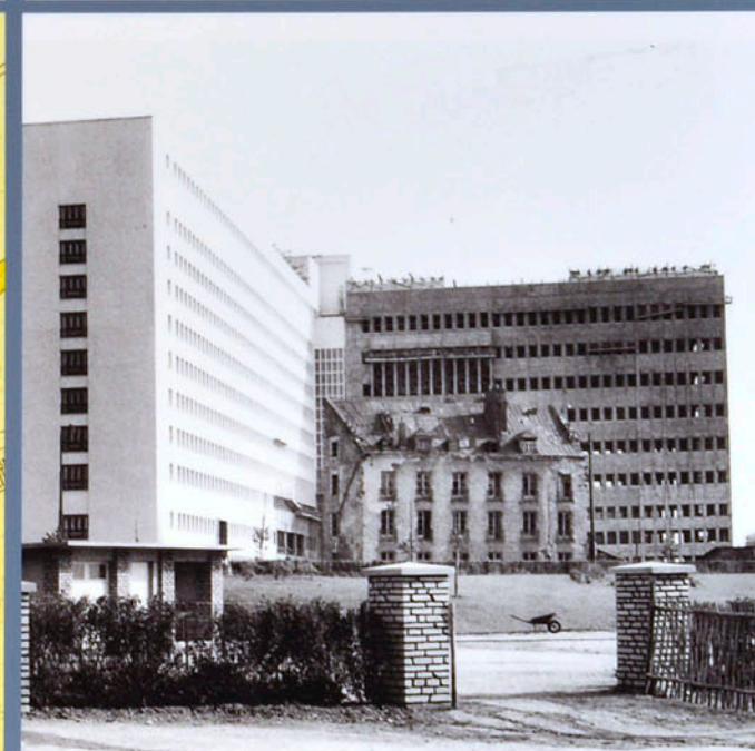
Construction du nouvel hôpital 4 mai 1960
