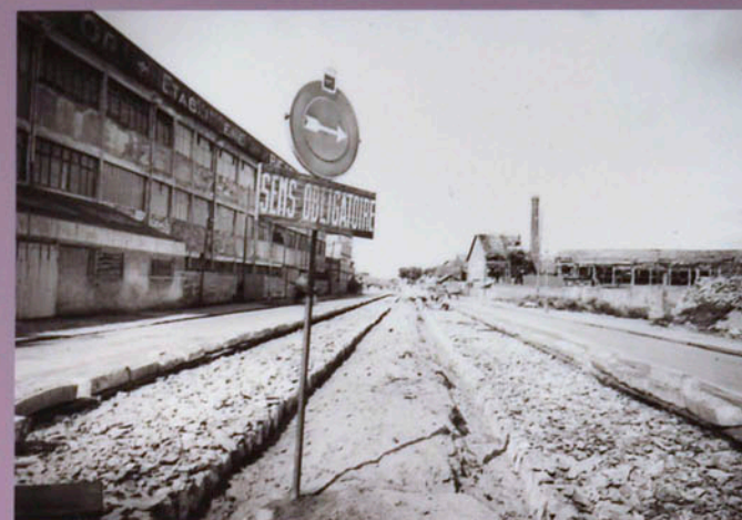
boulevard Gustave-Roch, juin 1946. Le boulevard Gustave-Roch fait partie du programme fixé le 26 juillet 1945 pour la rectification ou l'élargissement des voies anciennes. Le projet prévoit deux tranches : d'abord entre les Acieries Nantaises et l'avenue Carnot puis entre l'avenue Carnot et le bras de la Madeleine.
