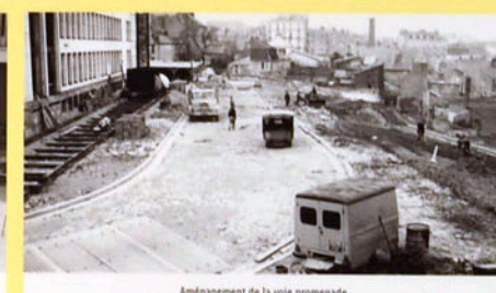
Aménagement de la voie piétonne.
