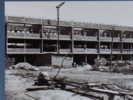
Construction de l'école de filles du boulevard Gustave Roch juin 1956
