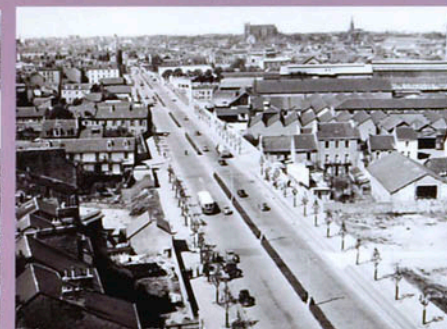
Dès l'ouverture du pont de Pirmil, le service de tramways en provenance du Pont du Cens est prolongé jusqu'au Lion d'Or et aux Trois Moulins. Les services d'autobus qui desservaient ces destinations sont supprimés.
