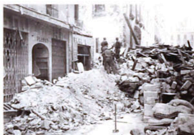
Immeubles détruits rue de l'Arche Sèche, septembre 1943
