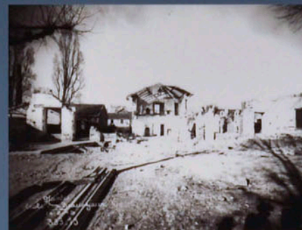
Ecole de la rue Beauséjour (actuelle rue Alexandre Fourmy) Construite en 1869 par l'architecte Gaillard, elle fut complètement détruite par les bombardements des 16 et 23 septembre 1943
