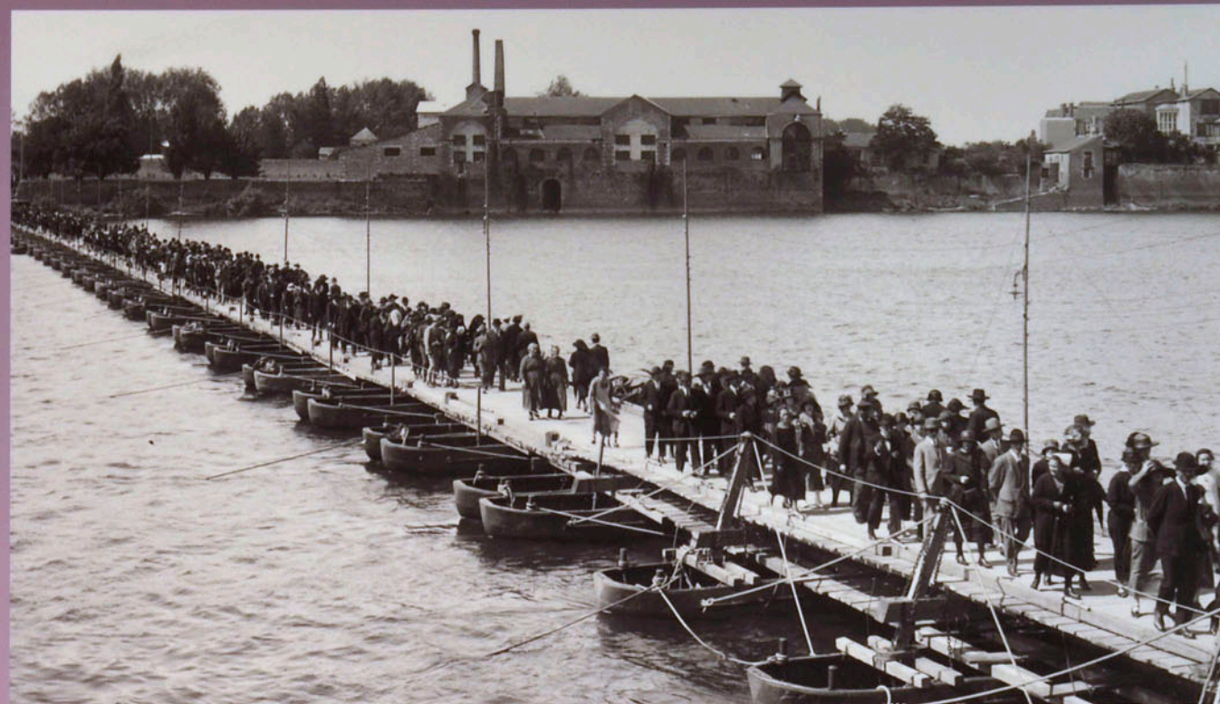
Pont de Pirmil détruit. Une passerelle flottante pour piétons est mise en place en septembre 1944. Longue de 300 mètres et large de 2 mètres, elle enregistre de véritables embouteillages aux heures d'affluence, correspondant à l'embauche et à la débauche des usines.
