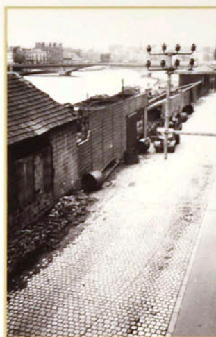
Amenagement des quais
