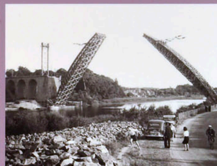
Pont de la Jonnelière. Cet ouvrage assure la ligne de chemin de fer Nantes-Châteaubriant. Détruit le 11 août 1944 par les Allemands, sa reconstruction commence à la fin de l'année 1946. Pour rétablir son tablier central, deux demi-cintres sont mis en place en juillet 1947. Le pont est inauguré le 3 août 1948.
