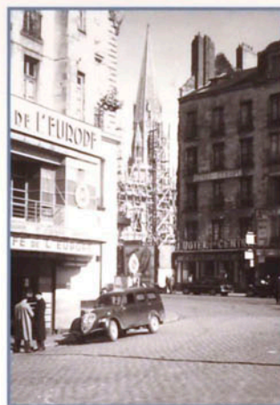
Église Saint Nicolas en restauration 25 mars 1950
