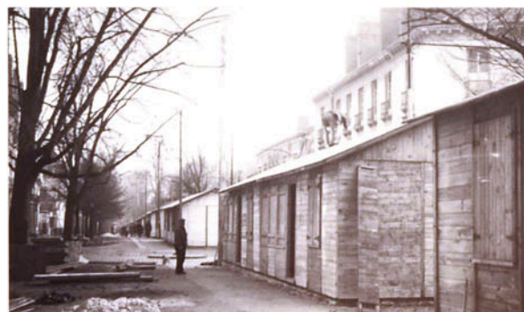
Construction de baraquements provisoires, après les bombardements, Boulevard Guist'hau.
