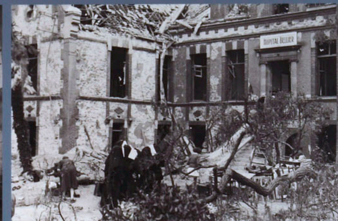
Hôpital Beilleville - Malgré les dégâts subis par les bâtiments, le matériel sanitaire, chirurgical, de radio et de couchage était majoritairement intact, si bien que l'hôpital put redémarrer rapidement, installé provisoirement dans une maison bourgeoise rue César Franck, avant d'être réhabilité.
