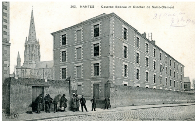
La caserne Bedeau, près de Saint-Clément, construite en 1842.
