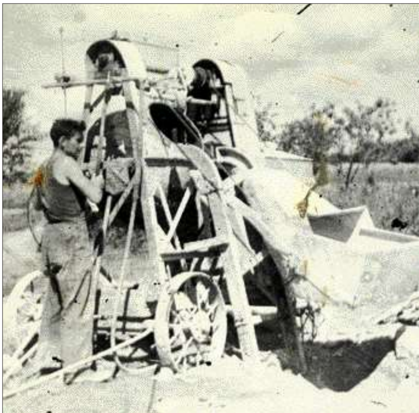
En plus de leur semaine de 48 h, les ouvriers devaient réserver à la construction de la cité un minimum de 24 heures par mois et une semaine sur la totalité des congés annuels.
