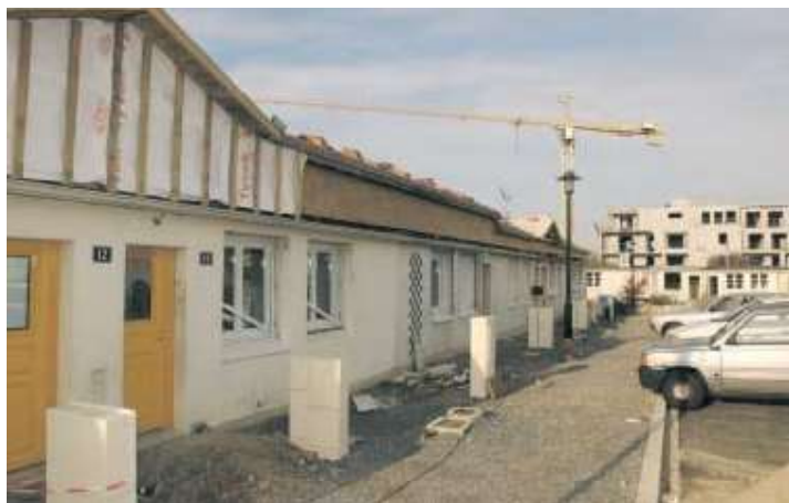
L'opération de réhabilitation engagée depuis mai 2002 s'achèvera en milieu d'année.
