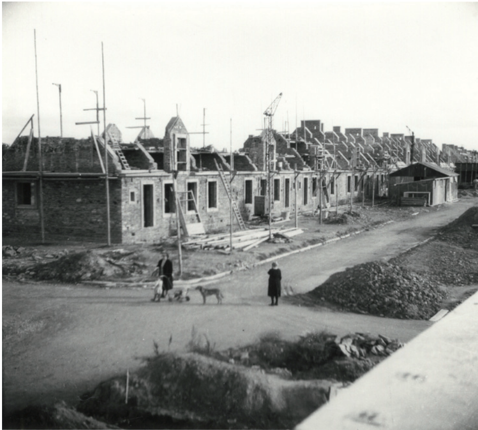
1947 - La cité du Grand Clos en chantier
