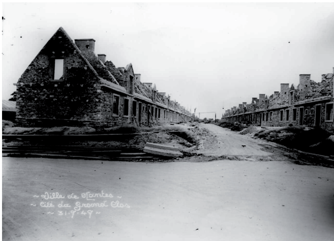
1947 - La cité du Grand Clos en chantier
