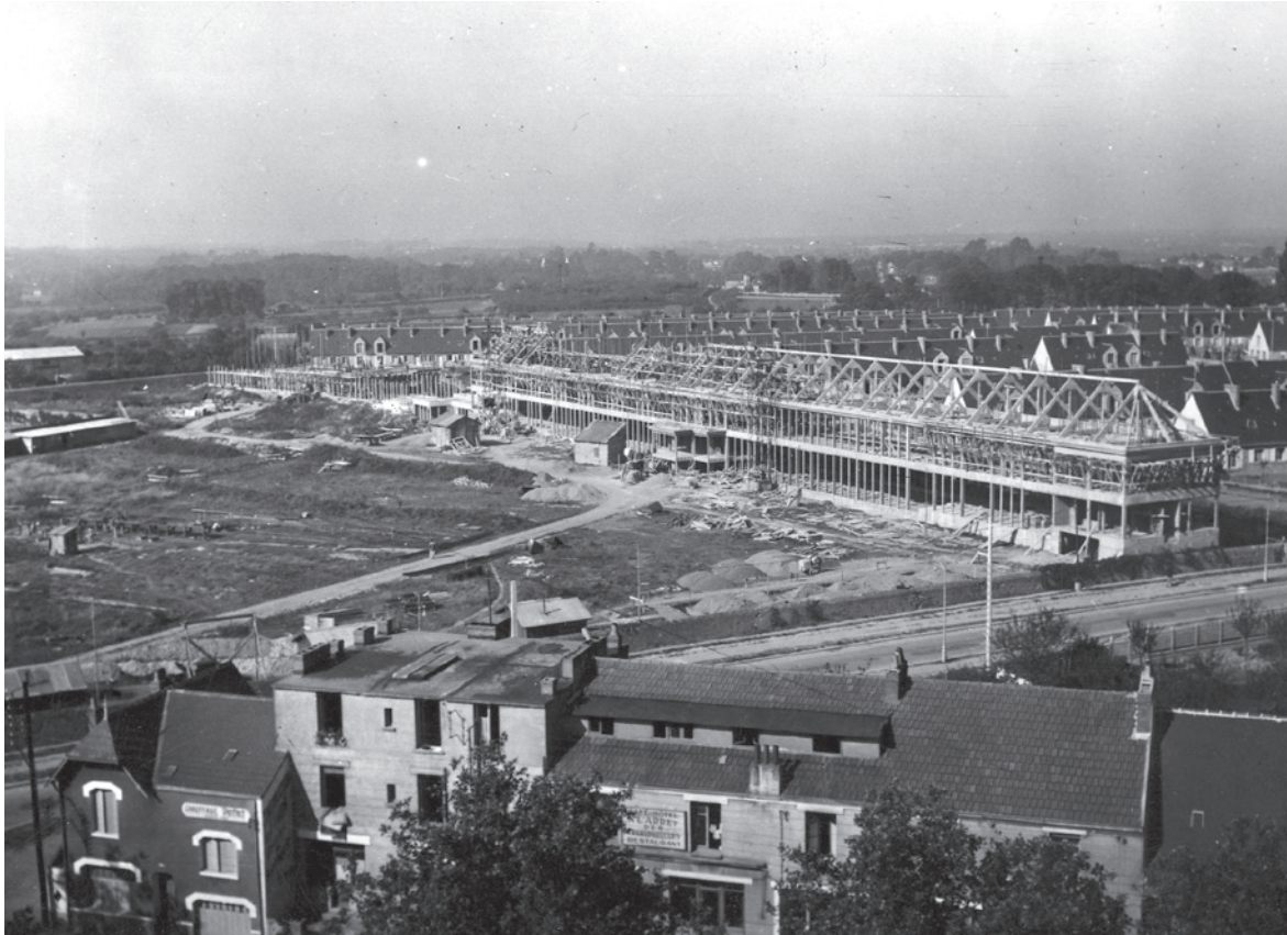
Construction de l'école de Marsauderies
